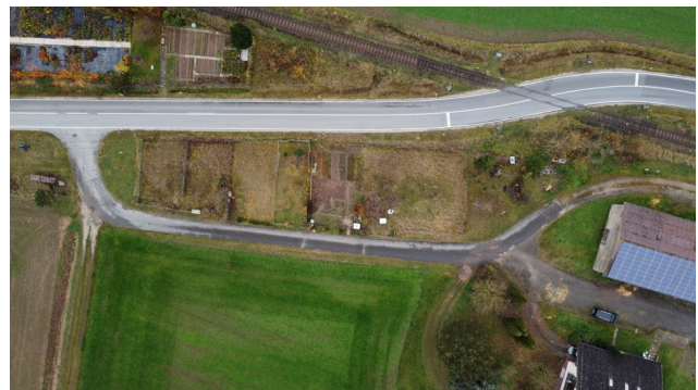
Drohnenaufnahme (VMB AG) Anschluss Staatsstraße
